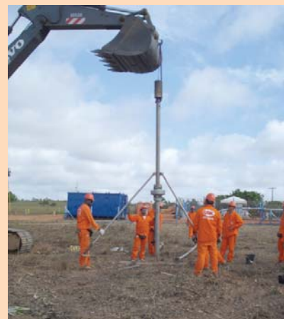
Conclusão da montagem dos queimadores
