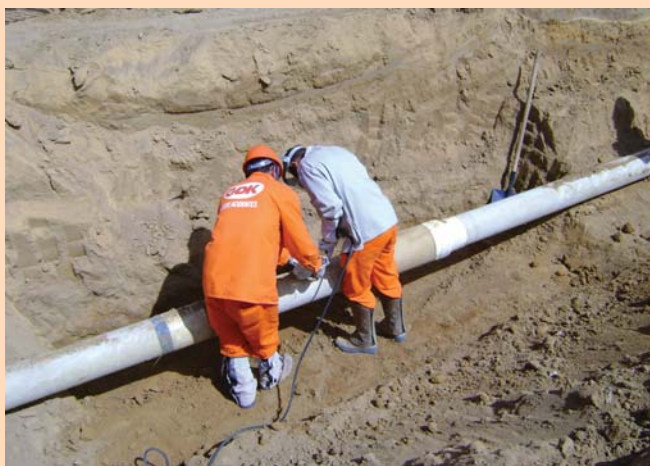
Realização de furo a frio com furadeira pneumática
