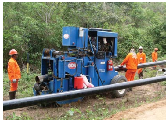
Curvamento de tubo
