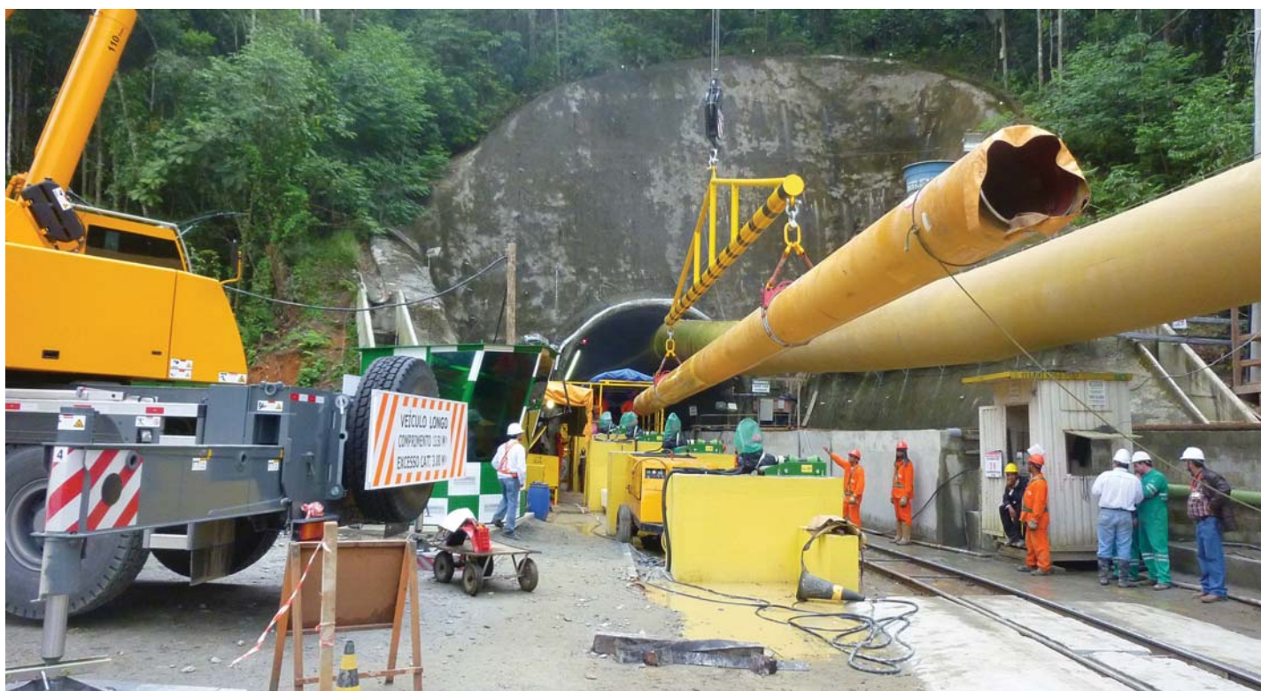
Acoplamento de double joint no emboque do túnel
