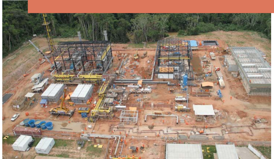
Serviços sendo executados na Ecomp de Coari
