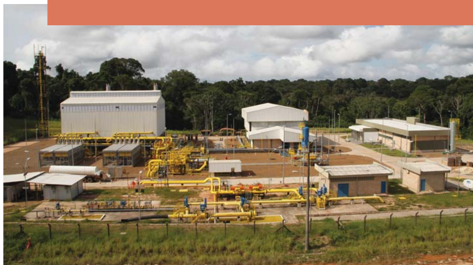
Vista Geral da Ecomp de Coari
