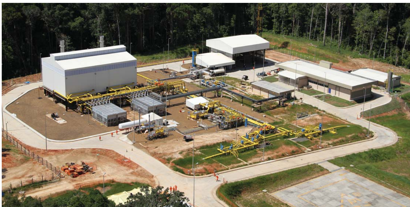
Vista Geral da Ecomp de Juaruna
